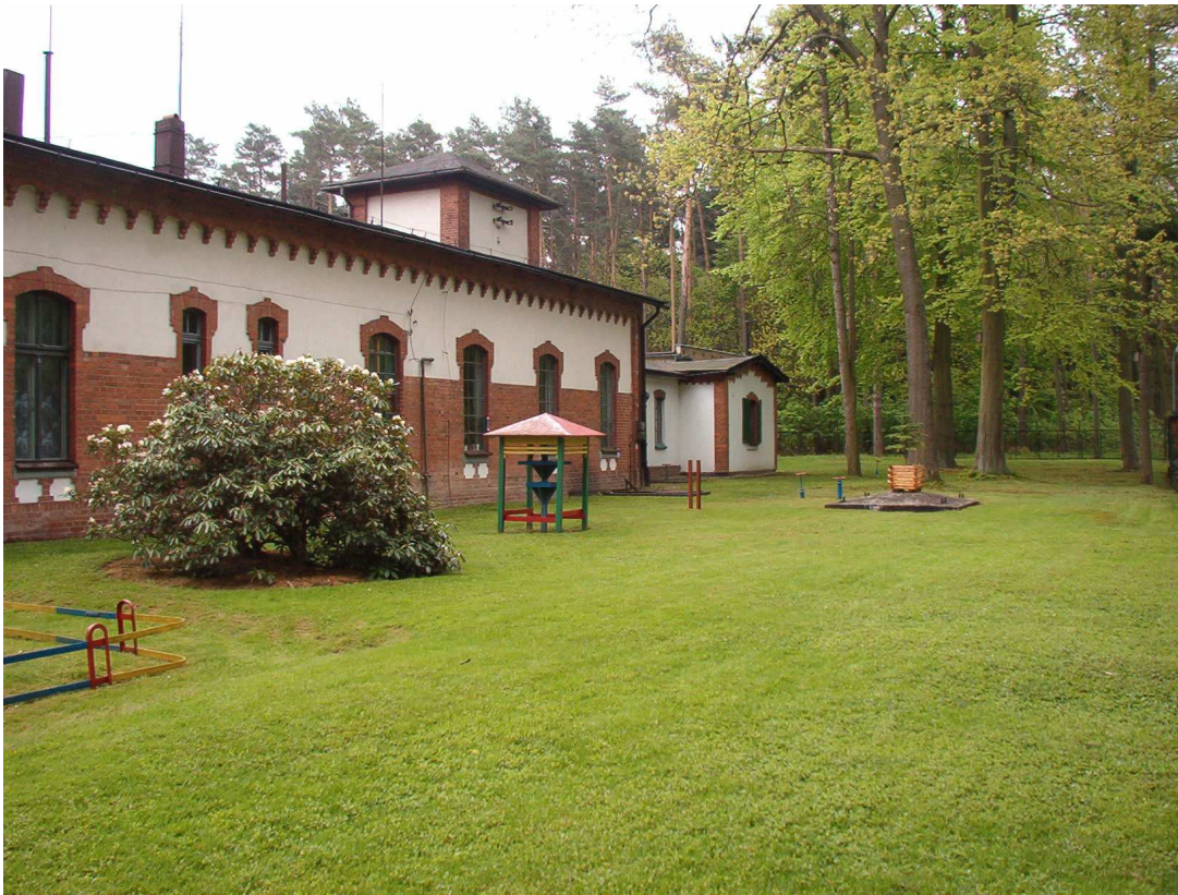
Stacja Uzdatniania Wody w Kluczborku
