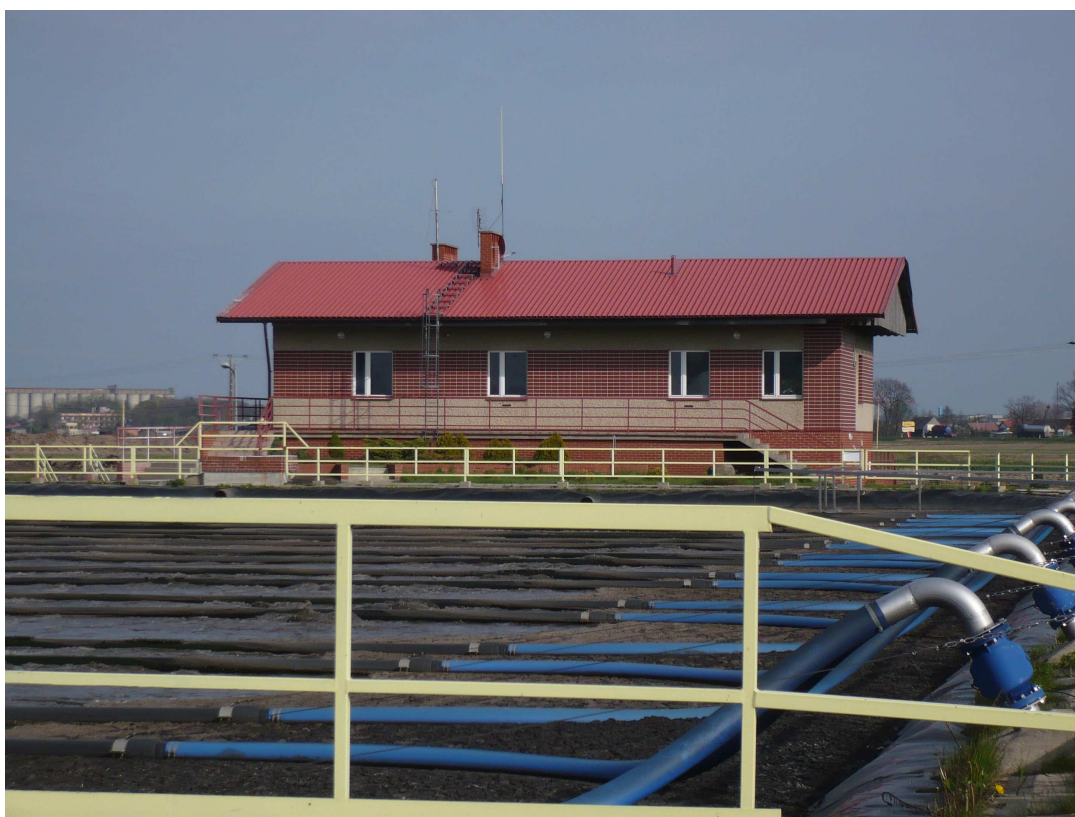
Oczyszczalnia ścieków w Ligocie Dolnej
