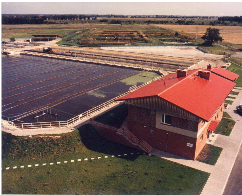
Oczyszczalnia ścieków w Ligocie Dolnej
