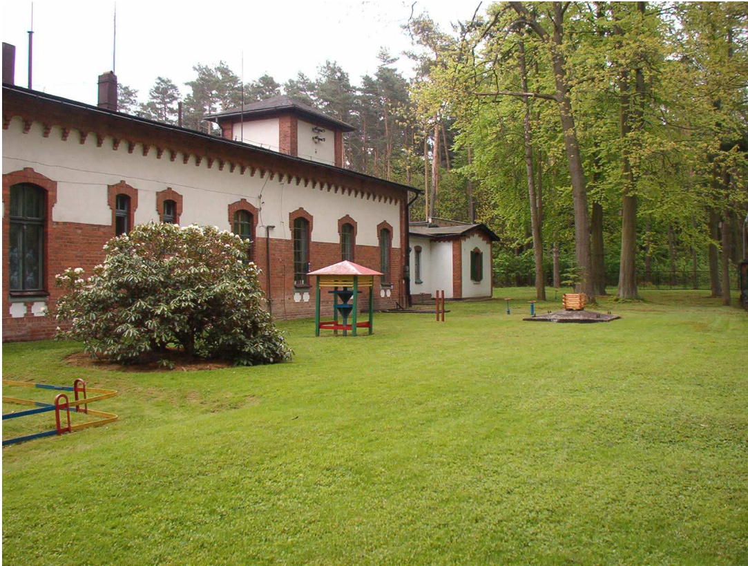
Stacja Uzdatniania Wody w Kluczborku
