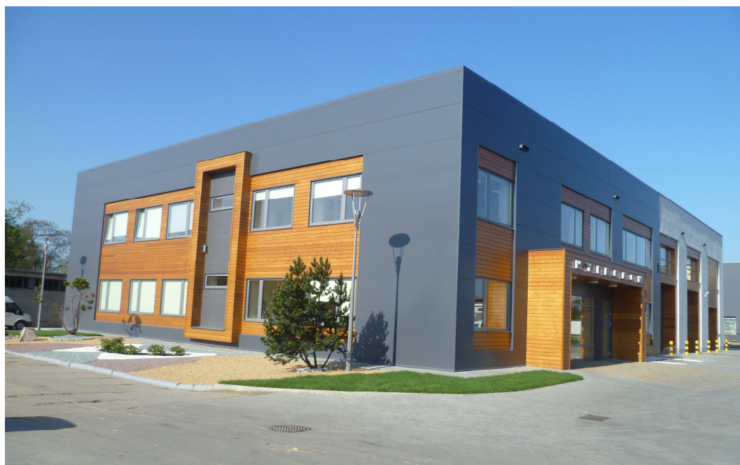
Budynek administracyjno-warsztatowy po modernizacji
