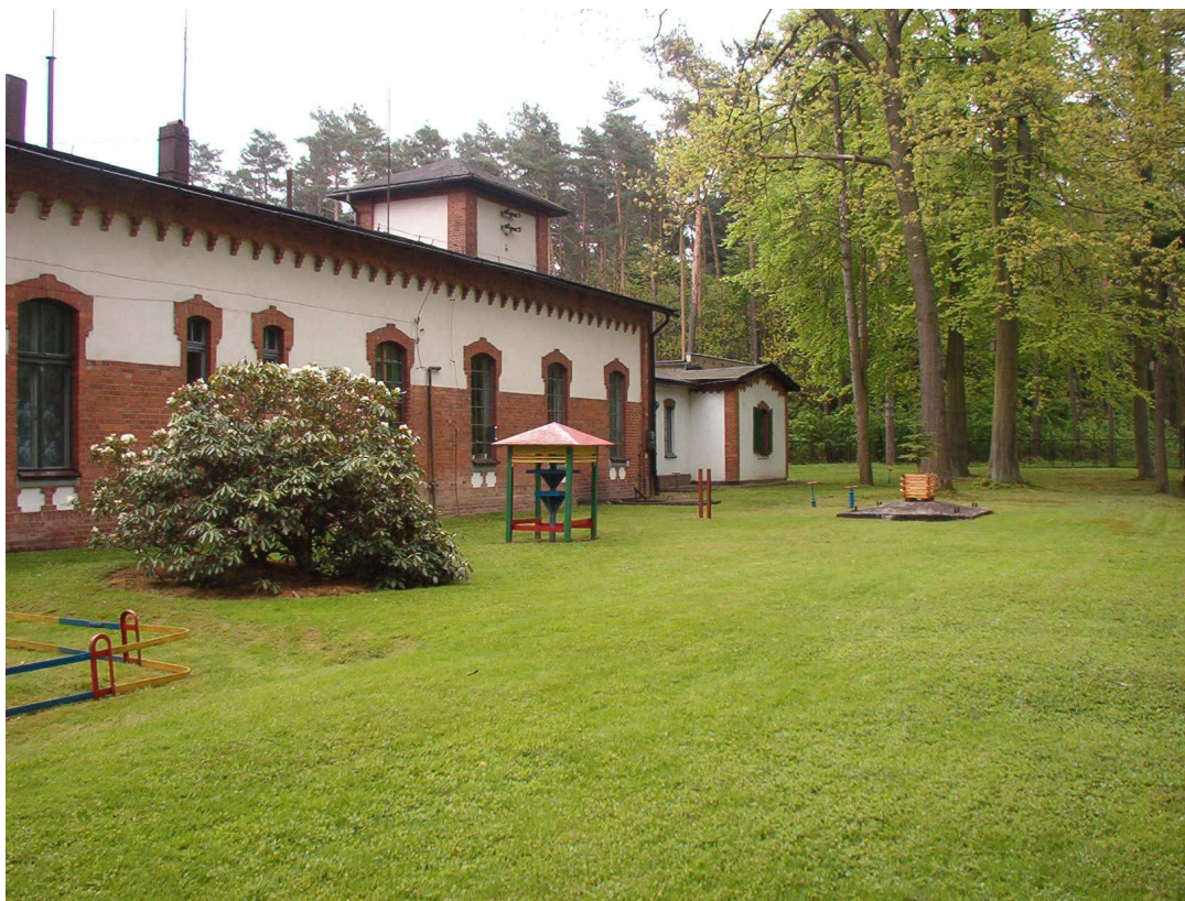
Stacja Uzdatniania Wody w Kluczborku
