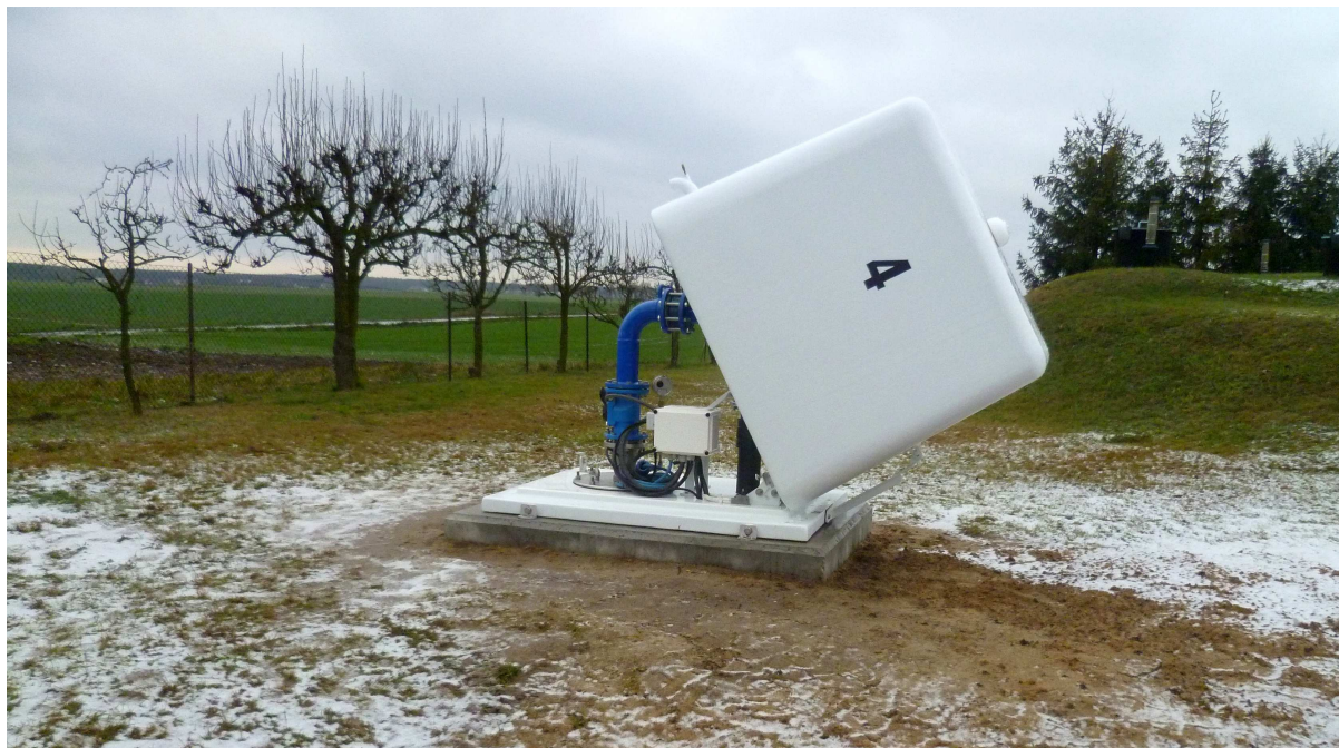
Obudowa studni nr 4 w Bogacicy
