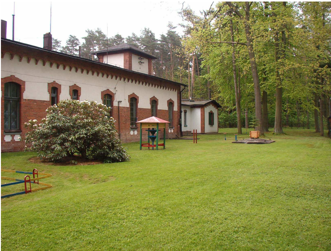
Stacja Uzdatniania Wody w Kluczborku
