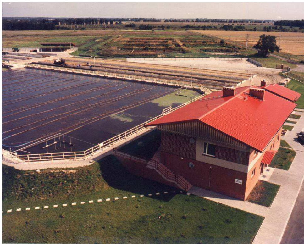
Oczyszczalnia ścieków w Ligocie Dolnej
