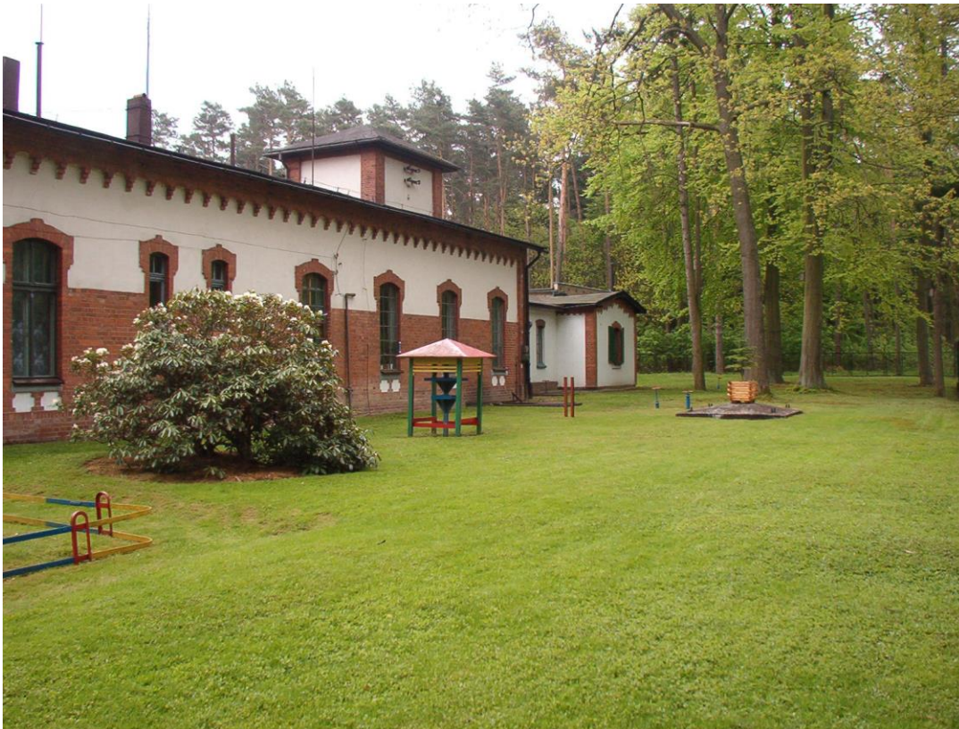
Stacja Uzdatniania Wody w Kluczborku przed modernizacją
