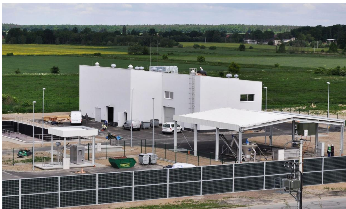
Oczyszczalnia ścieków w Ligocie Dolnej w trakcie rozbudowy i modernizacji – nowa część oczyszczania mechanicznego
