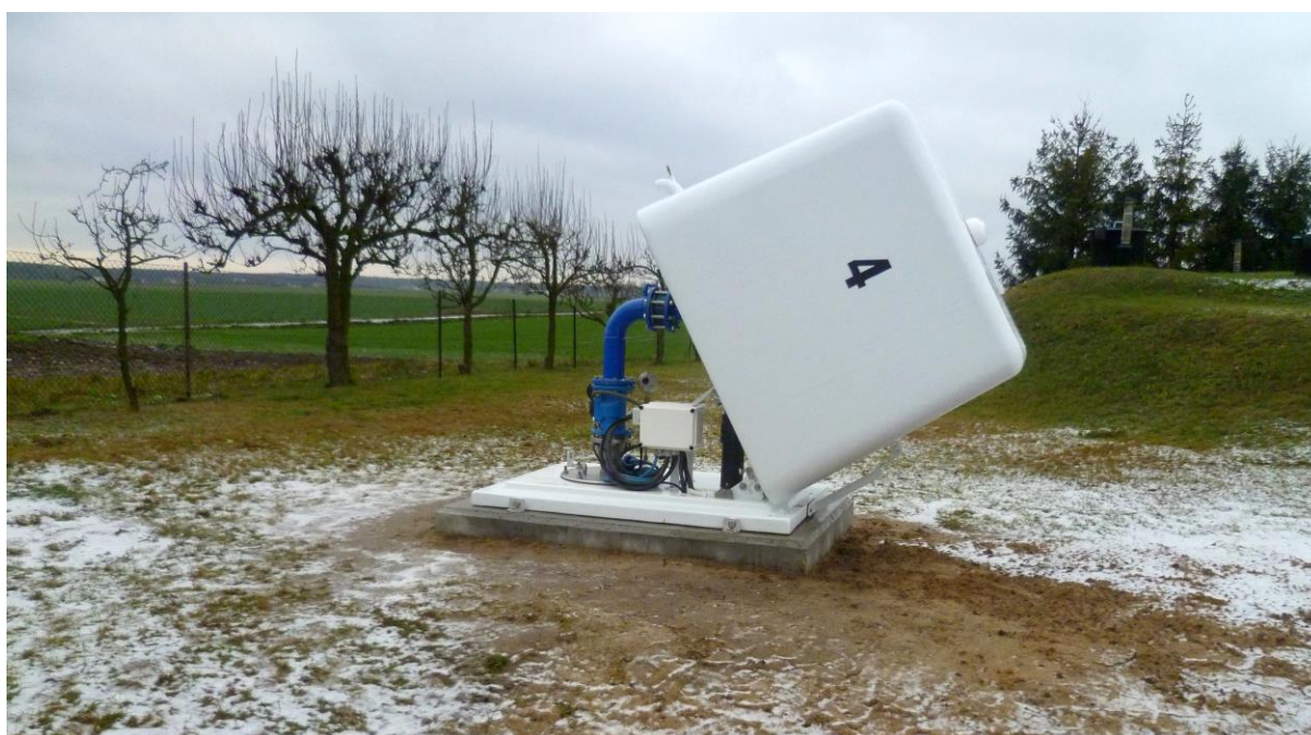
Obudowa studni nr 4 w Bogacicy
