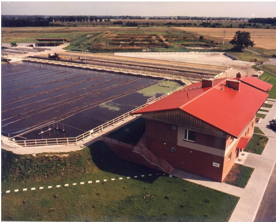
Oczyszczalnia ścieków w Ligocie Dolnej przed modernizacją
