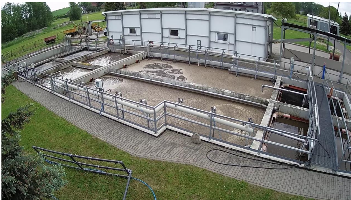
Oczyszczalnia ścieków w Byczynie
