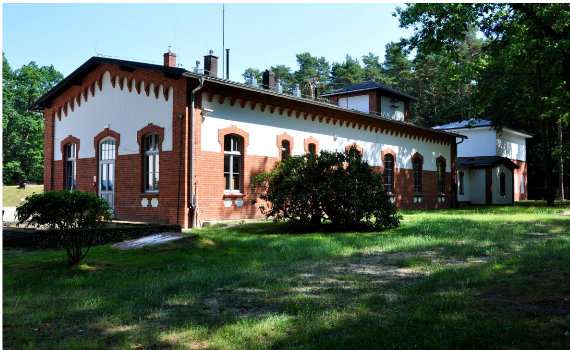
Stacja Uzdatniania Wody w Kluczborku po modernizacji
