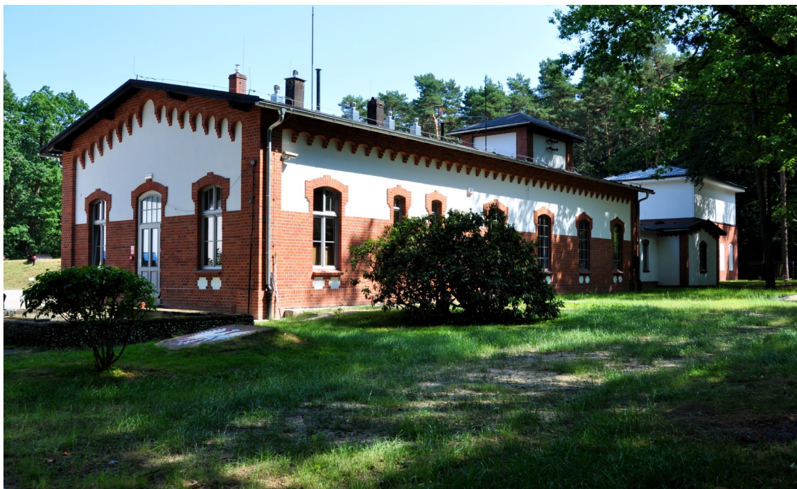
Stacja Uzdatniania Wody w Kluczborku po modernizacji
