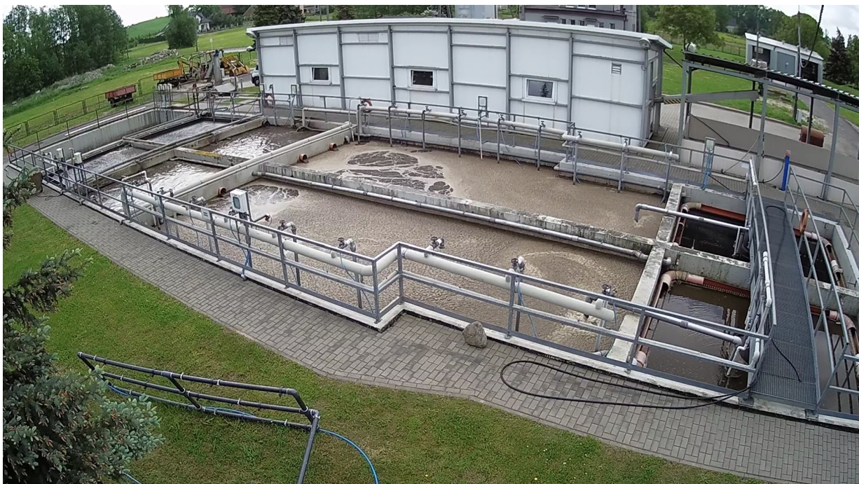
Oczyszczalnia ścieków w Byczynie
