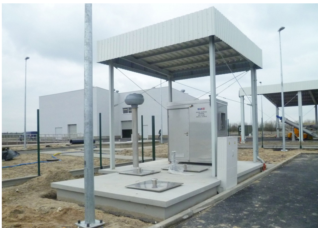
Nowa stacja zlewna ścieków dowożonych na oczyszczalni w Ligocie Dolnej
