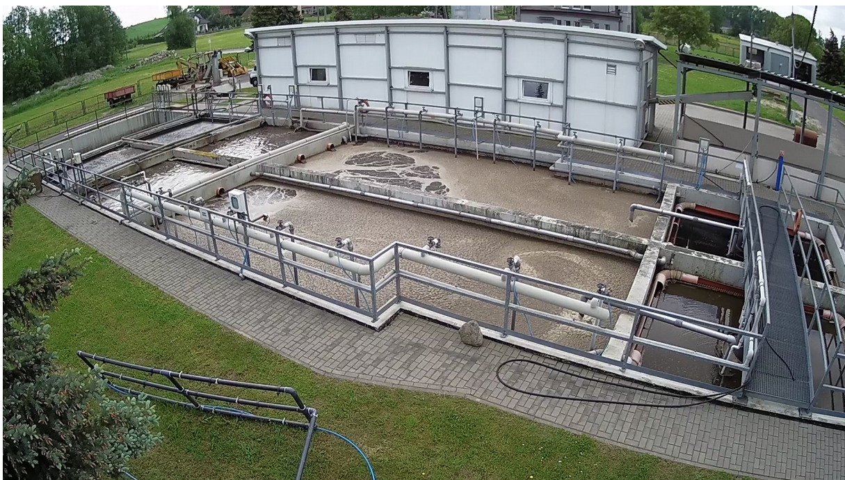
Oczyszczalnia ścieków w Byczynie
