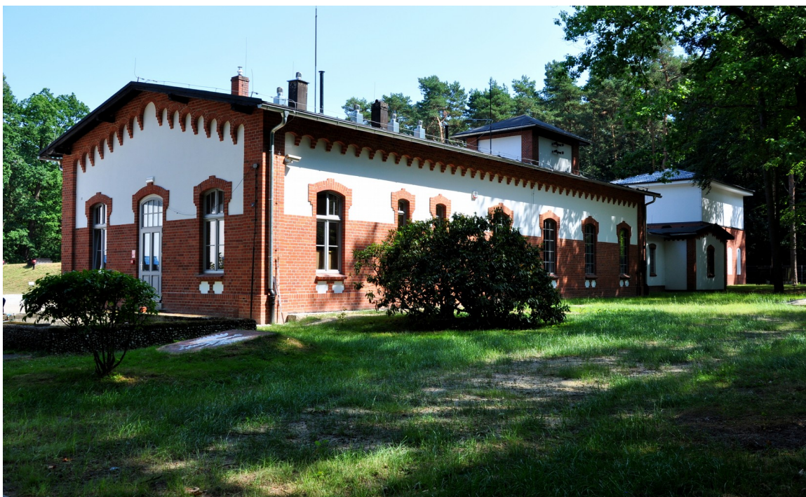
Stacja Uzdatniania Wody w Kluczborku po modernizacji
