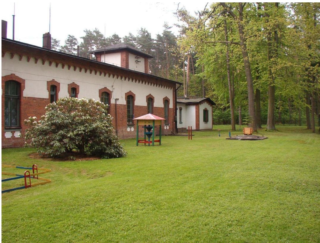
Stacja Uzdatniania Wody w Kluczborku
