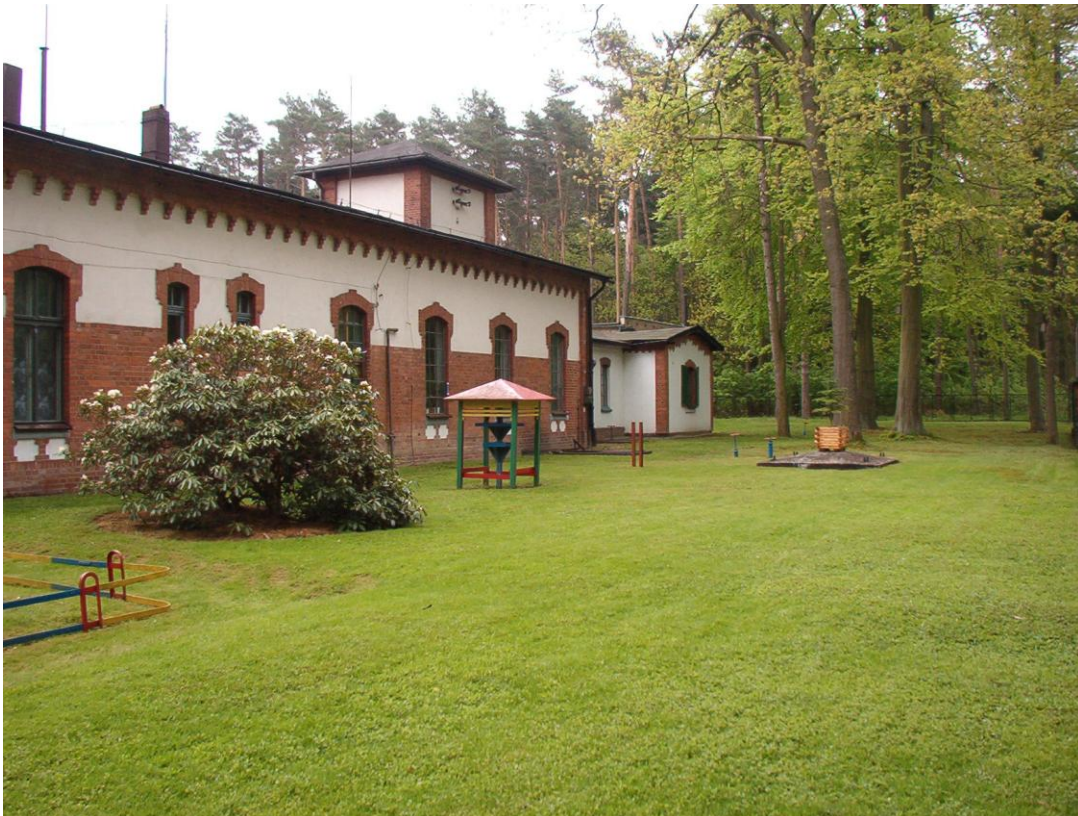
Stacja Uzdatniania Wody w Kluczborku
