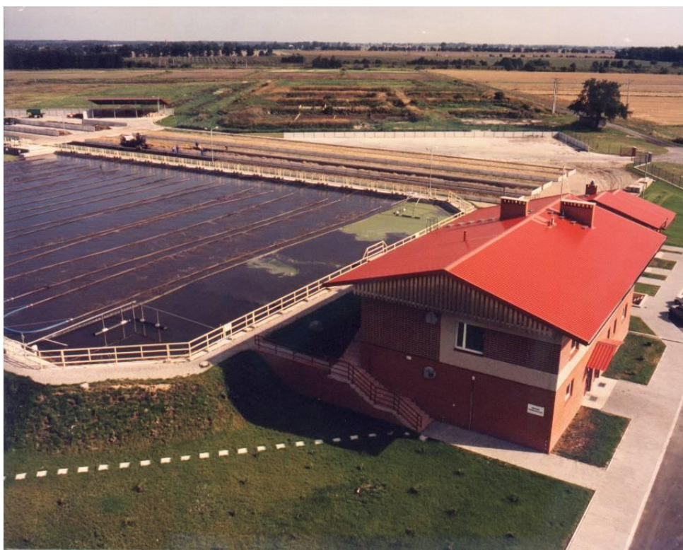
Oczyszczalnia ścieków w Ligocie Dolnej
