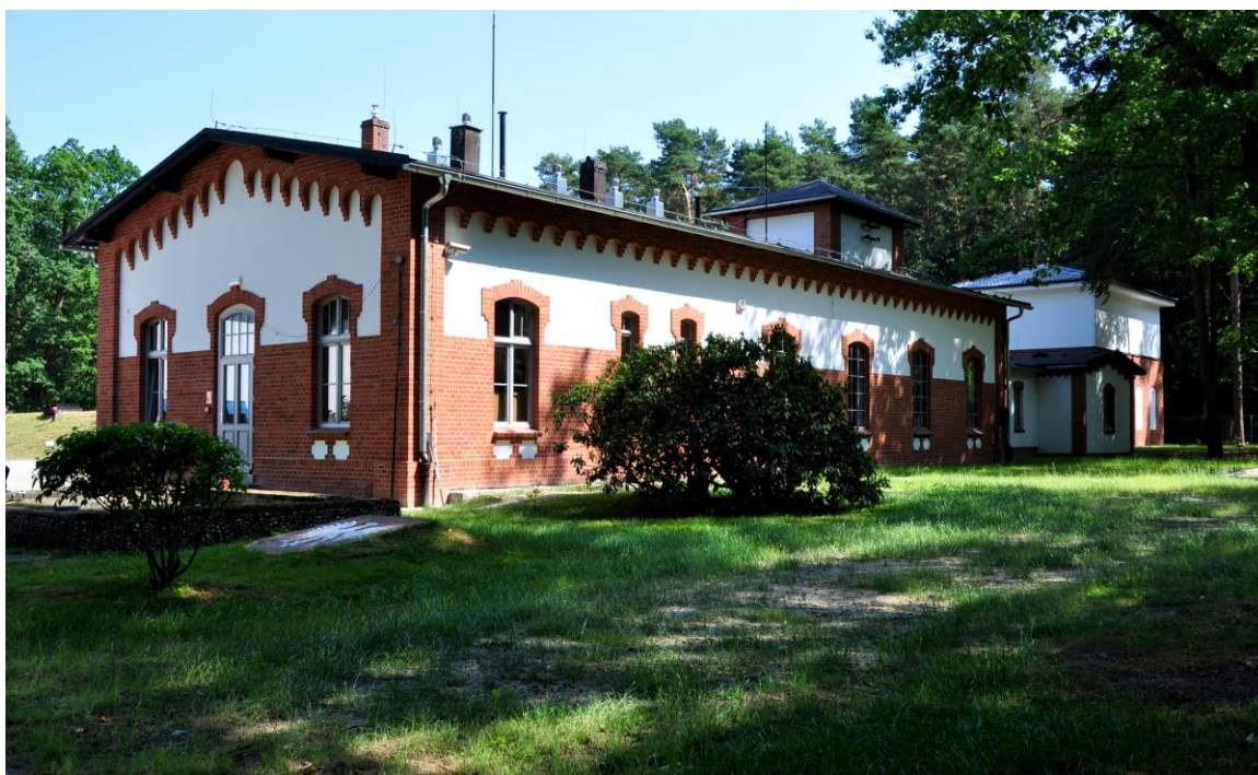
Stacja Uzdatniania Wody w Kluczborku po modernizacji
